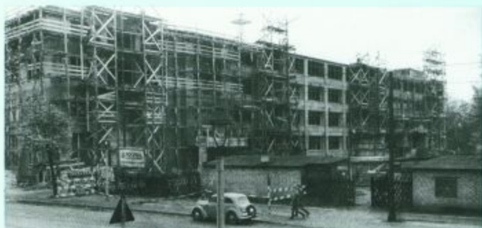
Haus 44/45 wird weitergebaut
